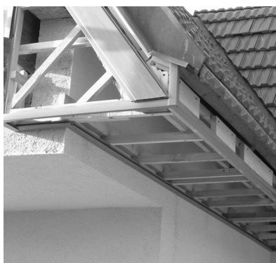
osazené ukonč. profily a první lamela
