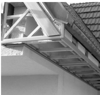
osazené ukonč. profily a první lamela
