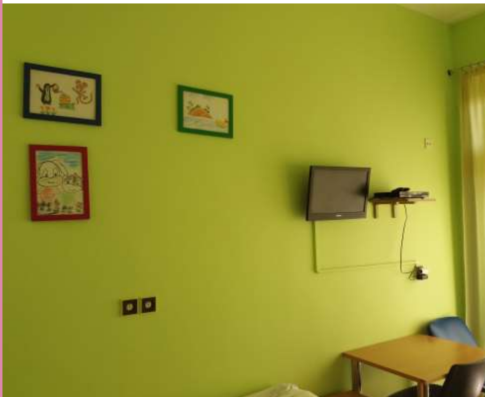
Fotografie: čelní stěna - před výmalbou
