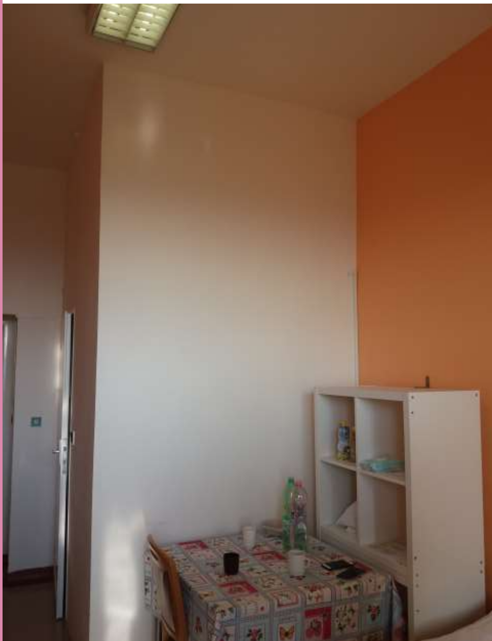
Fotografie: čelní stěna - před výmalbou
